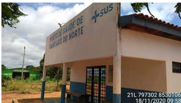
Figura 6.43 Posto de Saúde. Distrito de Santiago do Norte. Município de Paranatinga, MT.
